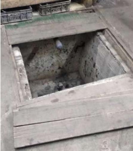
**Foto No. 3.** Estructura que cubre la boca del pozo
